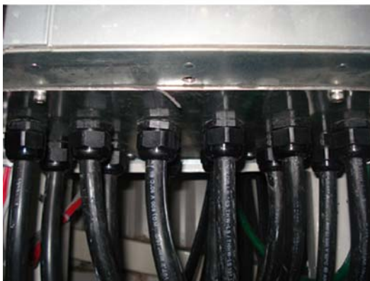
Рисунок 4.24: Пример правильной установки платы уплотнений.
