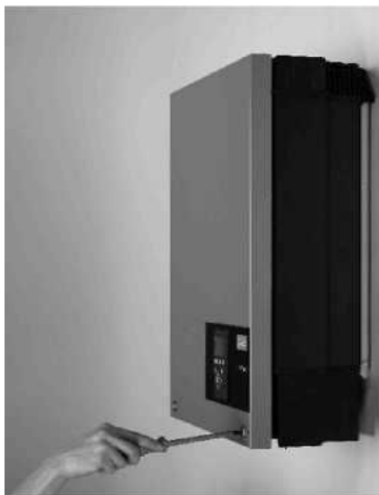
Иллюстрация 3.10: Затяните два винта на передней панели инвертора и обеспечьте правильное подключение защитного провода заземления.
