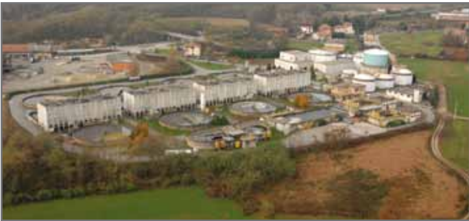
Микротурбина Capstone C200 на биогазе производит тепло и электроэнергию на водоочистой станции Cossato Spolina в городе Биелла, Италия.
